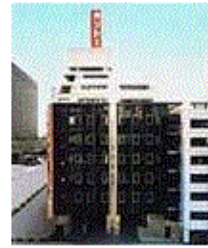
▲カントー本社ビル
